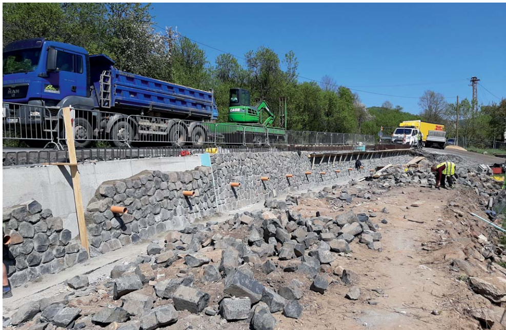
Opěrná zeď Starý Šachov
