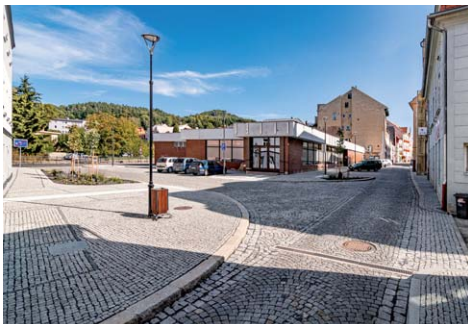
Oprava komunikací v České Kamenici
